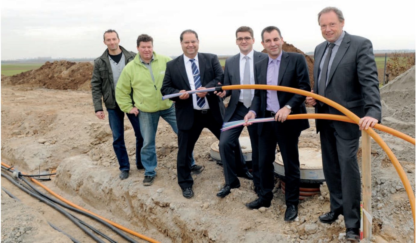
Die EWR Netz GmbH verlegt im Neubaugebiet 18 Morgen in Offstein Glasfaserkabel, über das inexio dann FTTH-Dienste darstellt.
